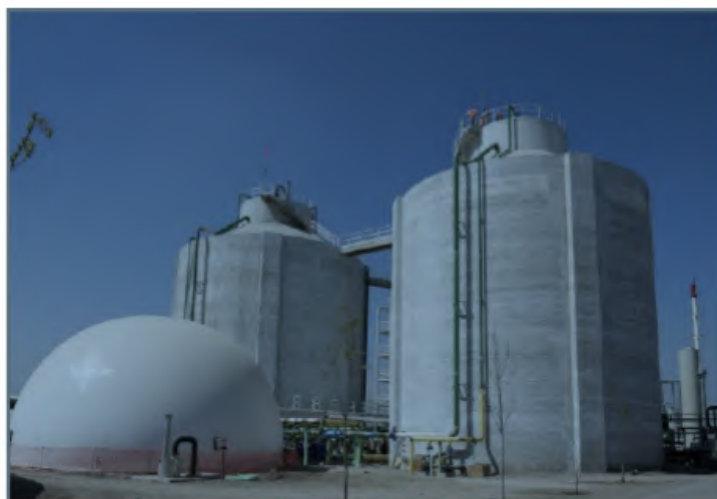
Figura 5 Planta de Biogás
